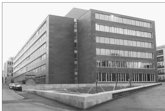
Auch das AI-Lab befindet sich nun im neuen Uni-Gebäude in Oerlikon.
