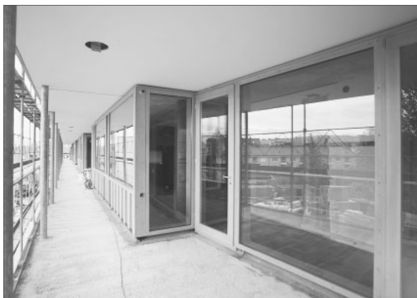
Wettergeschützte Laubengänge mit Holzrahmen und hohen Fenstern geben der neuen Siedlung an der Bülachstrasse ihr Gesicht. (Bild Frank Brüderli)
