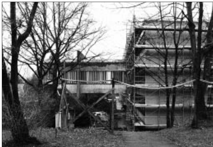
Die Haustechnikanlagen und die Gebäudehülle der Veterinärmedizinischen Fakultät müssen erneuert werden. Auch die neue Raumnutzung erfordert Umbauten. (Bild Zoran Ralievic)
