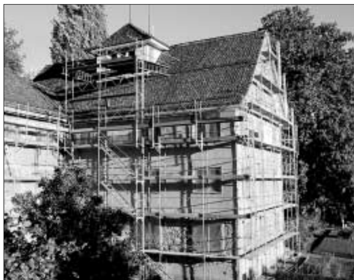
Alles wird neu, alles wird besser: Die Anlaufstelle für den Mittelbau befindet sich im Bodmerhaus, das zur Zeit renoviert wird. (Foto Christoph Schumacher)
